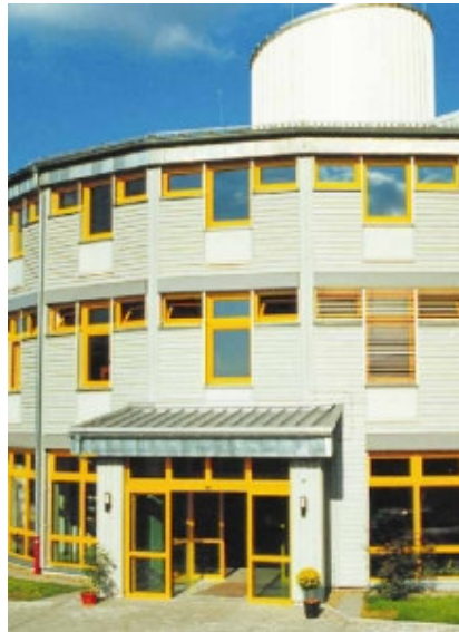
Abbildung 13: Bürogebäude Wagner & Co Solartechnik [Sol07 von Projektteam Wagner]
