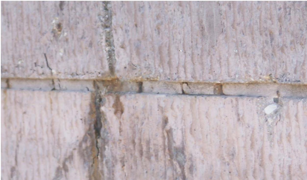
Die Bohrlöcher, welche offenbar von einem Witzbold als Scherz erstellt wurden, tragen nichts zu einer Fassadenbelüftung bei, weil sie aus thermodynamischer Sicht absolut funktionslos und nutzlos sind.
