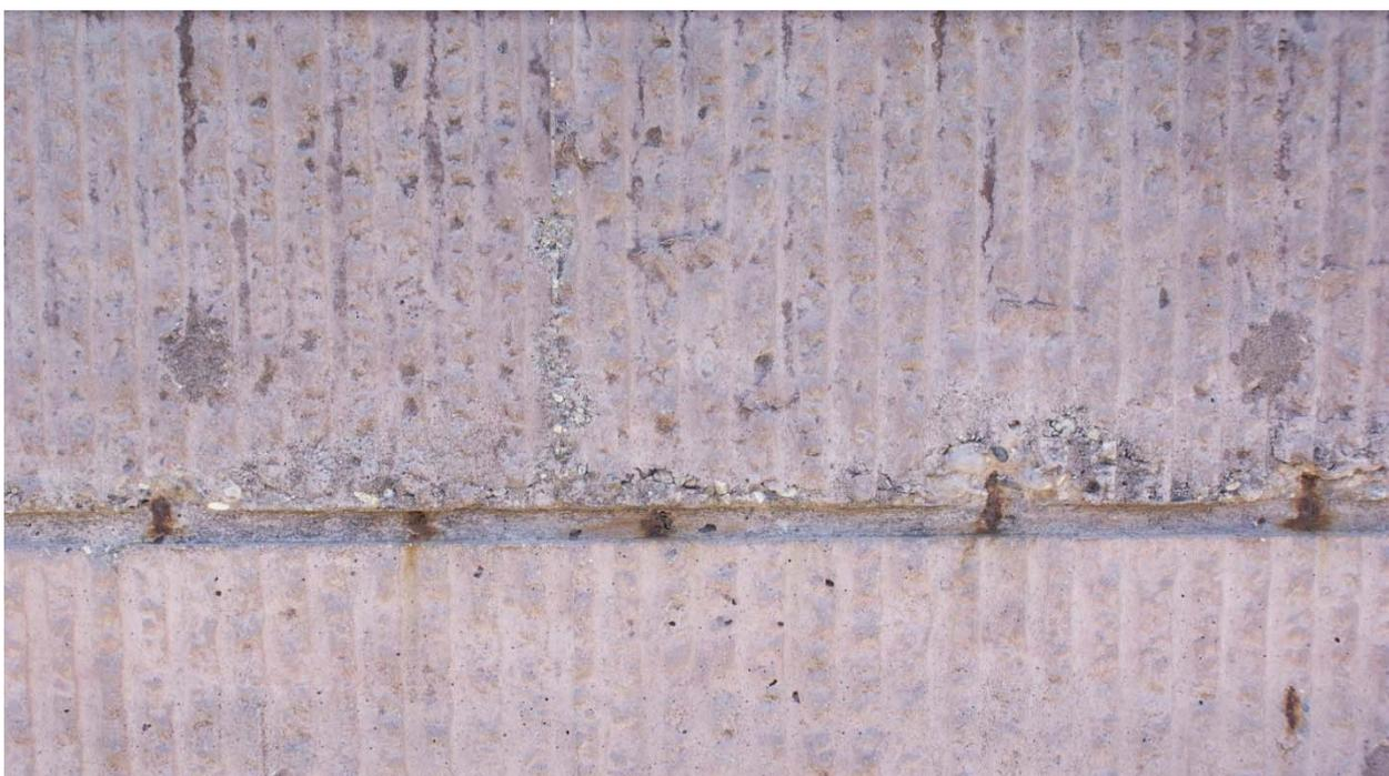
Betonrisse bei Platten-Fugen infolge Spannungsdifferenzen können mühelos mit geeignetem und eingefärbtem Mörtel dauerhaft geflickt werden. Aus statisch konstruktiver Sicht ergeben sich keine Bedenken.
