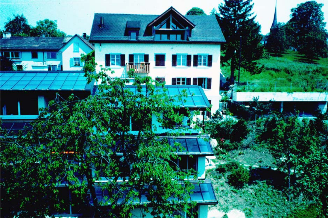
Solarthermie Zürich-Witikon: Südfassade rechts, von oben, 1981
