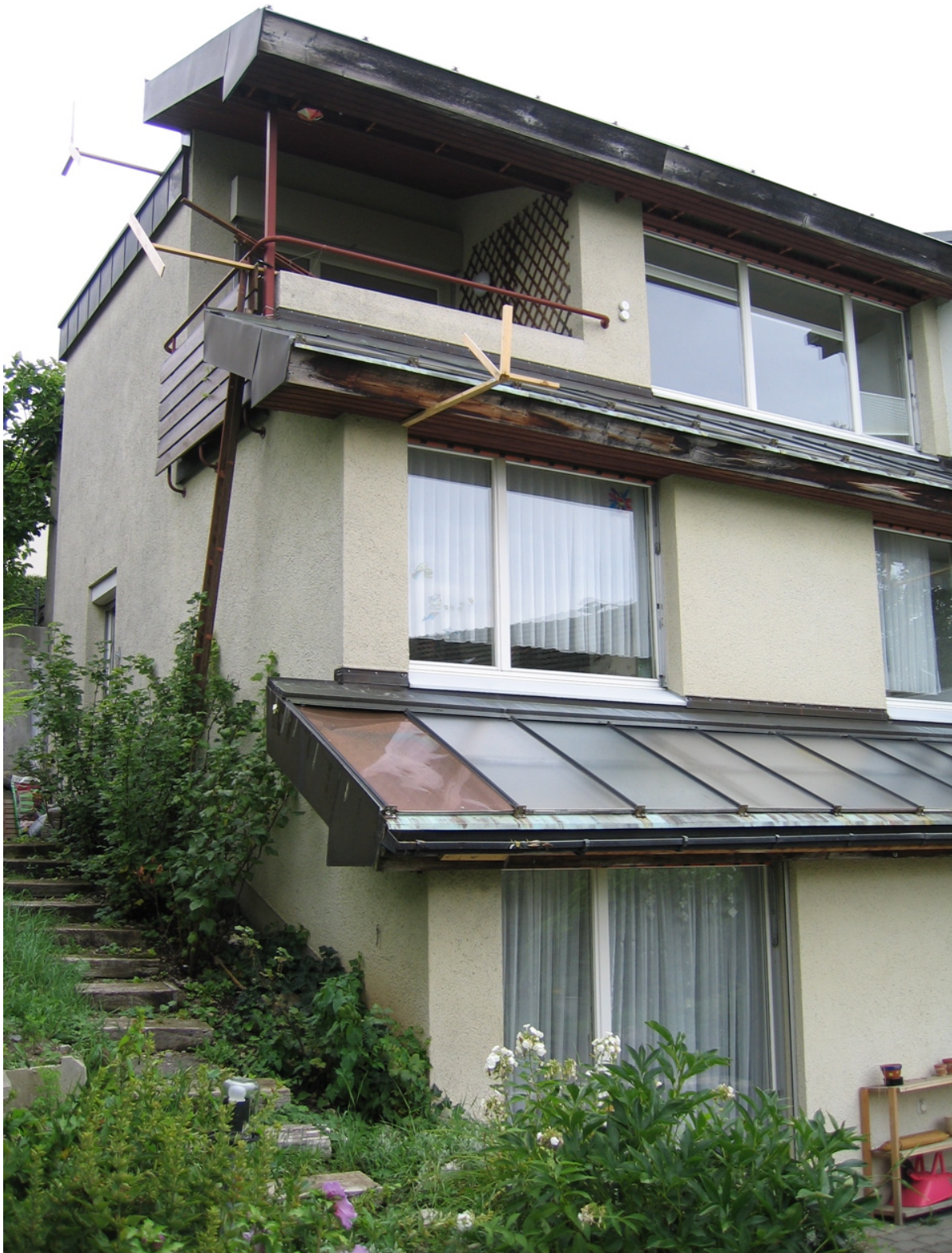
Solarthermie Zürich-Witikon: Südfassade links, seitlich, 2005
