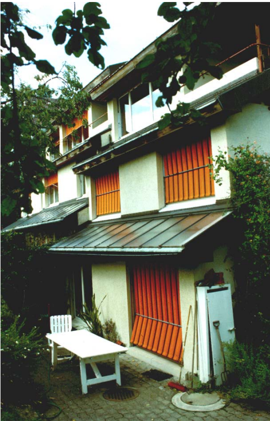
Solarthermie Zürich-Witikon: Südfassade rechts, seitlich, 1981
